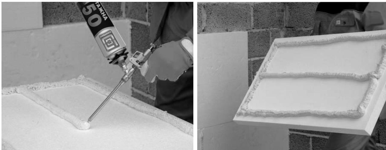
**Рисунок 2.** Способы нанесения клея на поверхность плит утеплителя.
